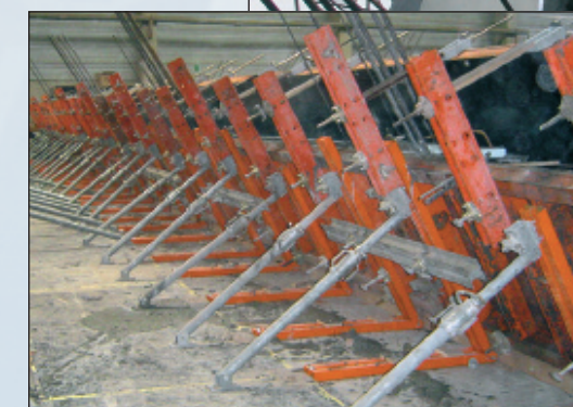
Cordeel Temse - Trapeziumvormige kolomprefab - Universiteit Gent.
