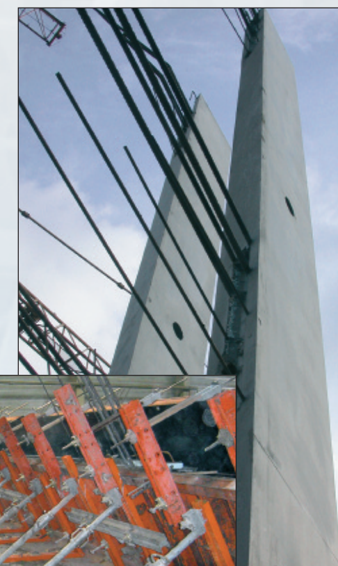
Cordeel Temse - Trapeziumvormige kolomprefab - Universiteit Gent.
